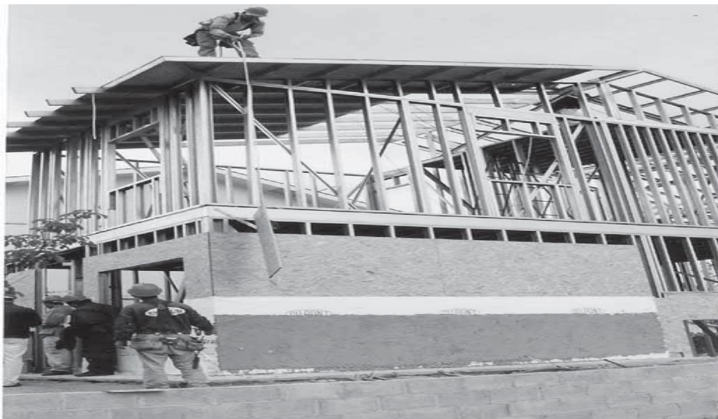
Figura 3 – Instalação de placas sobre o telhado
