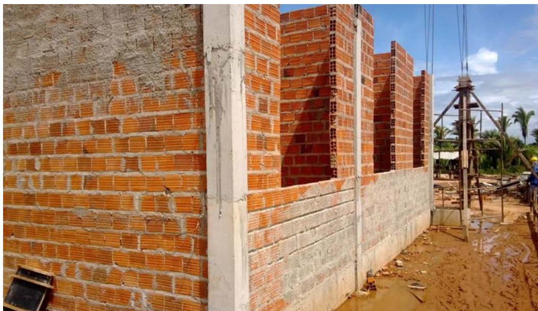
Figura 1 – Sistema construtivo convencional
