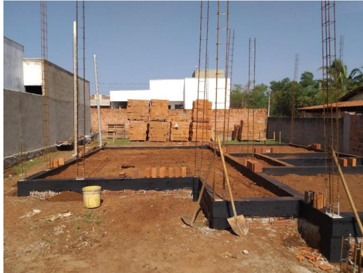
Figura 2: Utilização de tinta asfáltica impermeável
