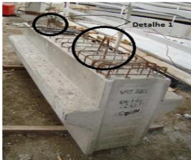
Figura 7- Viga suporte-protendida Fonte: Henry Seden (2015)
