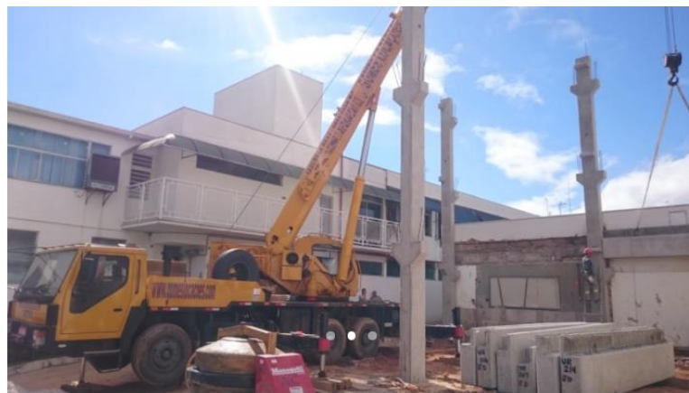
Figura 9 - Guindaste acoplado em um caminhão Fonte: Gomes Locações (2019)
