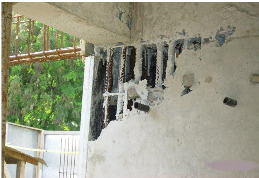
Figura 3: nicho de concretagem.
