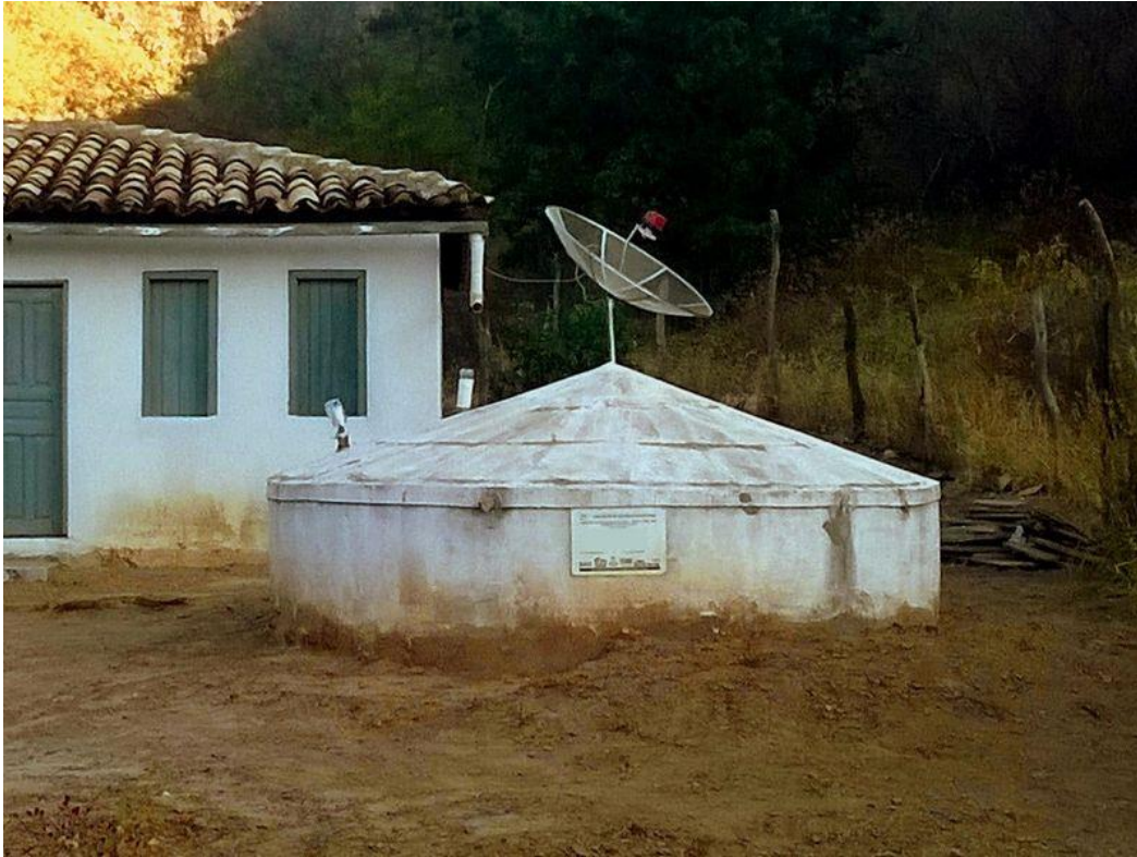
Figura 03: Cisterna de Placa
