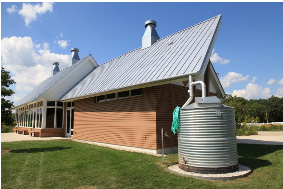
Figura 04: Cisterna de Aço
