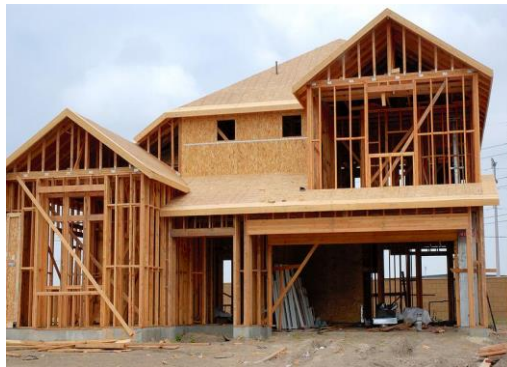
Figura 1: Estrutura de madeira em wood frame.
