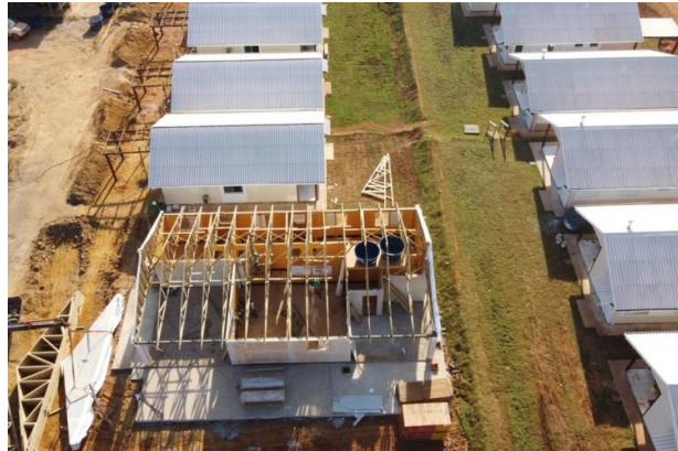
Figura 6: Residencial em Aripuanã, Mato Grosso, construído em wood frame.
