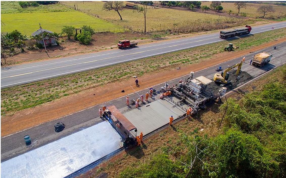
Figura 5: Execução do Pavimento
