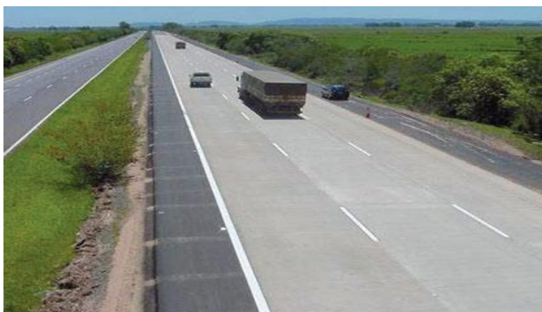
Figura 3: Visibilidade das Marcações nas Estradas.
