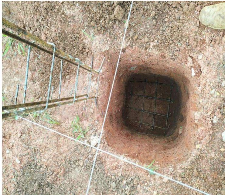
Figura 1 – Escavação e armadura da sapata
