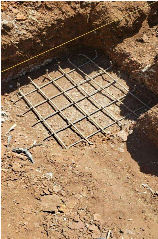
Figura 4 – Armadura da Sapata
