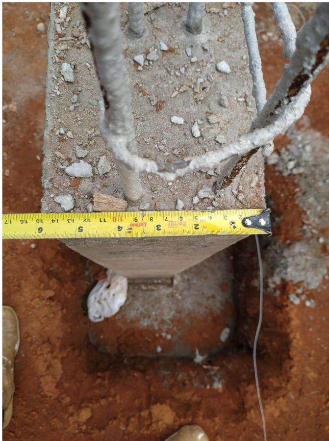
Figura 5 – Sapata e pescoço do pilar concretada
