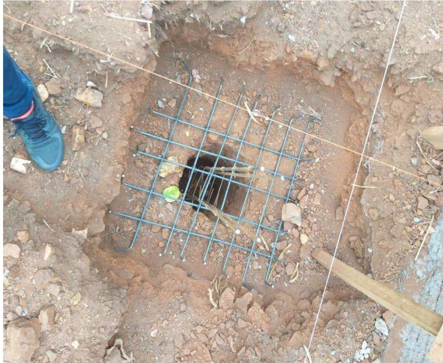
Figura 2 – Broca e armadura da sapata
