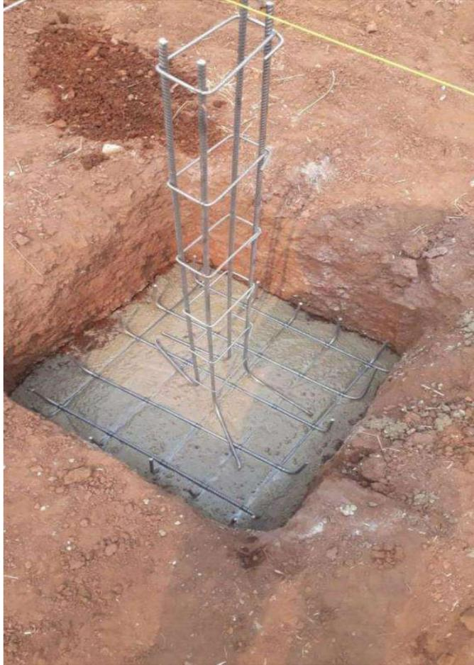
Figura 3 – Armadura da sapata e coluna pescoço do pilar
