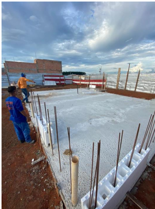
Figura 2 – Execução de residência em blocos de EPS.
