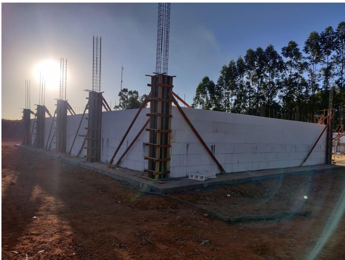
Figura 1 – Execução de residência em blocos de EPS.
