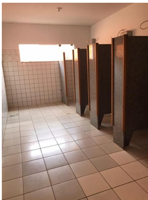
Figura 4 – Banheiros Escola D
