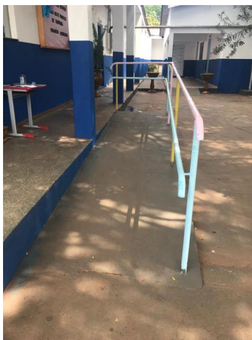
Figura 1 – Rampa de acesso na entrada Escola A
